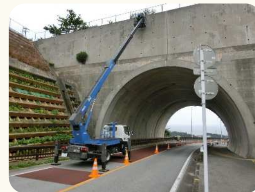
(トンネル点検-高所作業車) 県道86号線第1トンネル
