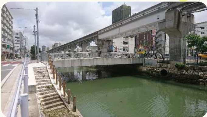
(橋梁) 久美橋 那覇市 久茂地川
