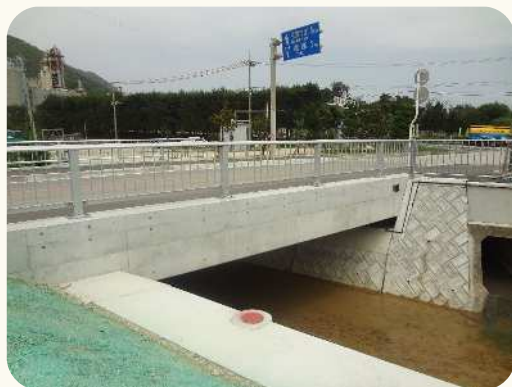
(門形カルバート) 国道449号線 名護市安和地内
