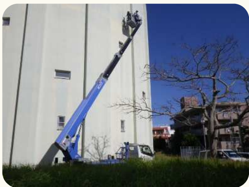
(貯水タンク点検-高所作業車) 那覇市真地配水池
