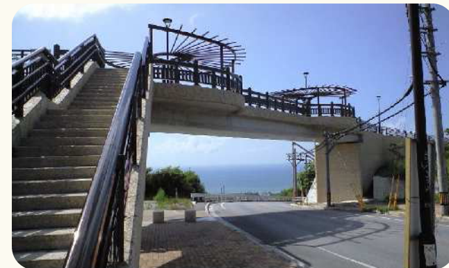
(人道橋) 中城村南上原地区 区画整備事業
