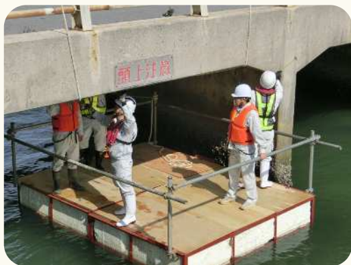
(橋梁点検-台船) 北谷町安良波線
