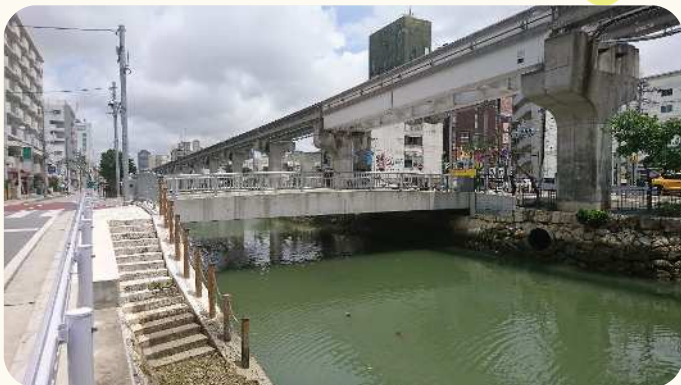
(橋梁) 久美橋 那覇市 久茂地川
