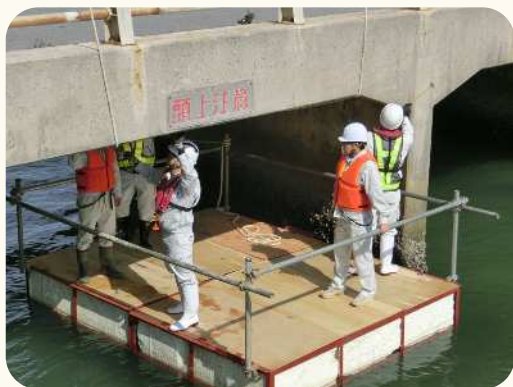
(橋梁点検-台船) 北谷町安良波線
