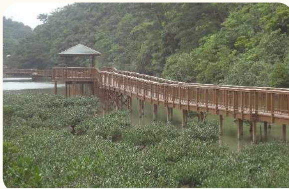
(マングローブ林内遊歩道) 名護市字大浦地内
