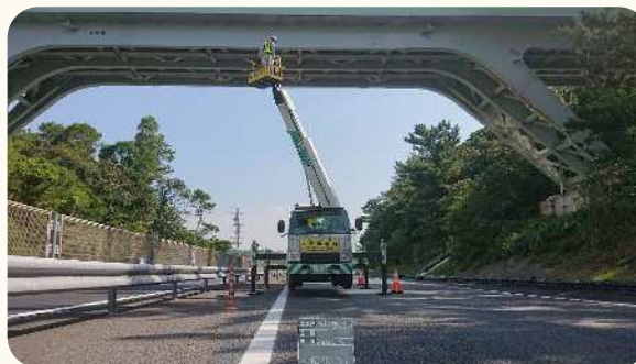
(橋梁点検-高所作業車) 金武町 町道伊芸27号線 川田原橋
