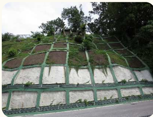
(法面对策) 名護市中央公園入口左側法面
