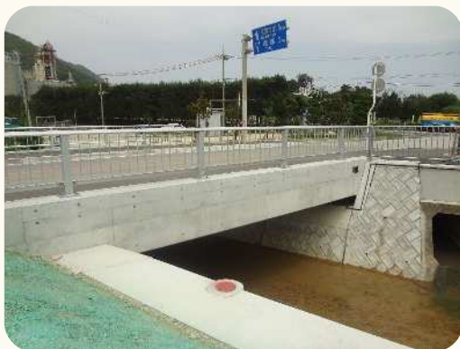
(門型カルバート) 国道449号線 名護市安和地内
